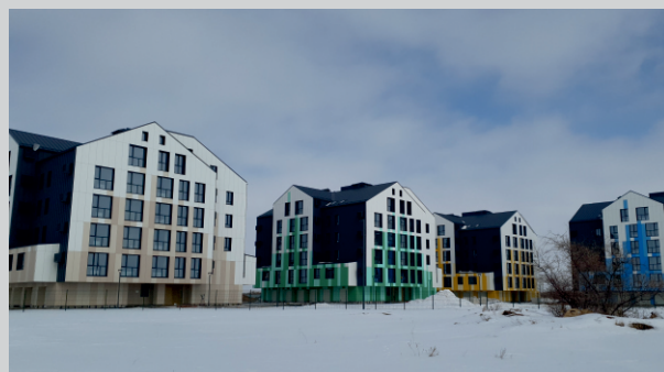
8. МЖК "Gold Land" (внутр. эл.монтаж) Ул. Е 344, уч. 5, 09. 09. 2021г.
