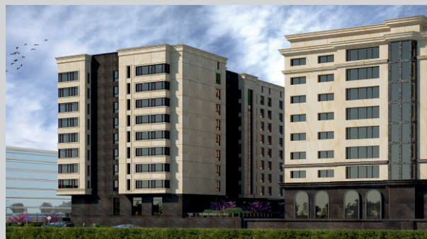
10. МЖК "Бахыт" (наруж. сети 0,4кВ; 10кВ) ТОО "БГМ"
