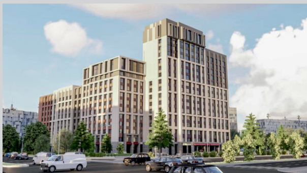
1. МЖК "Angleterre" (внутр. эл.монтаж, наруж. сети 0,4кВ) Ул. Хусейн бен Талал, уч. 28, ул. Мангилик Ел 84, 16. 09. 2021г.
