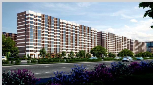
4. МЖК "Budapest" (внутр. эл.монтаж, наруж. сети 0,4кВ) Ул. Кабанбай батыра, уч. 59, 08. 06. 2021г.
