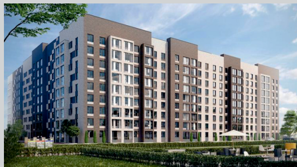
2. МЖК "Аркада" (внутр. эл.монтаж, наруж. сети 0,4кВ) Ул. 200(Ильяс Омарова), уч. 31, 19. 07. 2021г.
