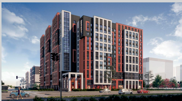
15. МЖК "Жеруйык" (внутр. эл.монтаж, наруж. сети 0,4кВ) ул. Кенесары За 07. 11. 2020г.
