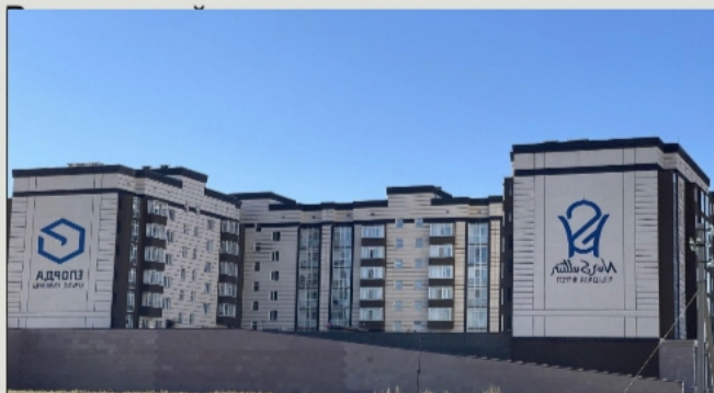
МЖК «Талисман» (р-н Есиль, Е542-Е567); Электромонтаж НЭС 20 кВ и Оптика.
