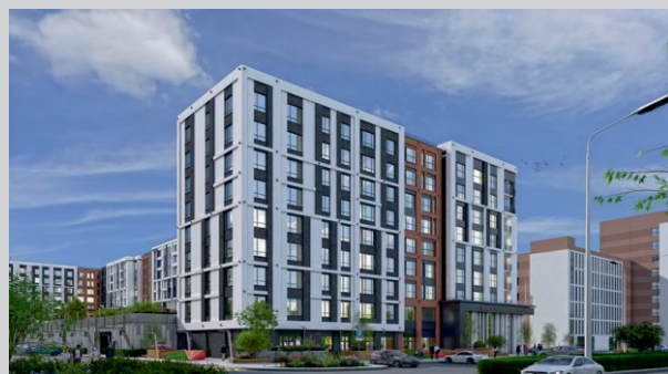
14. МЖК "Атмосфера" (внутр. эл.монтаж, наруж. сети 0,4кВ) Ул. 200(Ильяс Омарова) 30. 07. 2021г.
